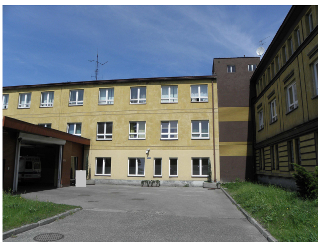
Zdjęcie 8 Elewacja południowa
