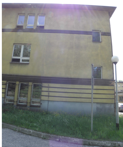
Zdjęcie 3 Elewacja północna
