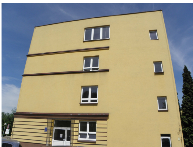
Zdjęcie 9 Elewacja południowa
