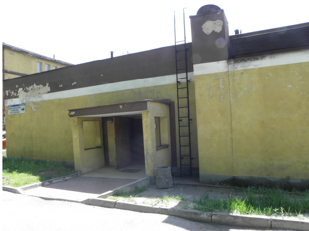
Zdjęcie 5 Elewacja północna
