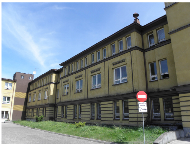
Zdjęcie 7 Elewacja zachodnia
