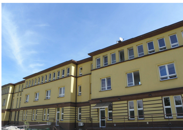
Zdjęcie 6 Elewacja zachodnia
