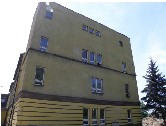
Zdjęcie 4 Elewacja północna
